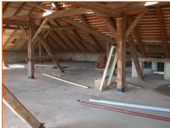
Nova betonska plošča.
