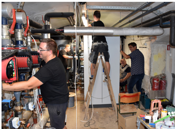
Montaža nove toplotne črpalke
